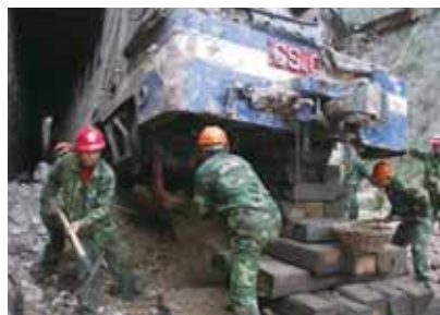
中铁一局、中铁电气化局109隧道抢险现场
