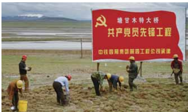
将施工中需要触动的草皮进行移植
