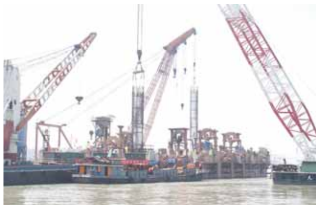
南京大胜关长江大桥施工过程中严格对废弃物进行环保处理
