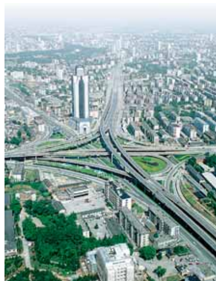
◎ 合肥五里墩立交桥
