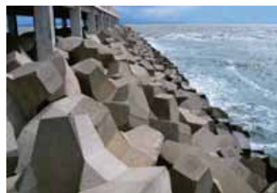
● 沿海防浪堤工程
