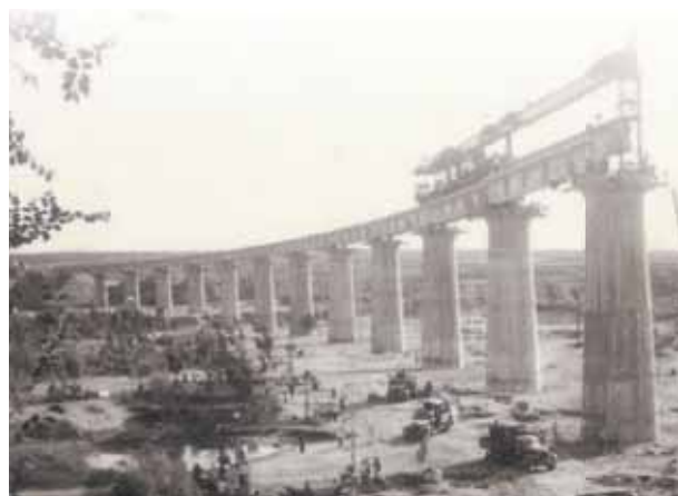
◎ 远赴非洲援建坦赞铁路
