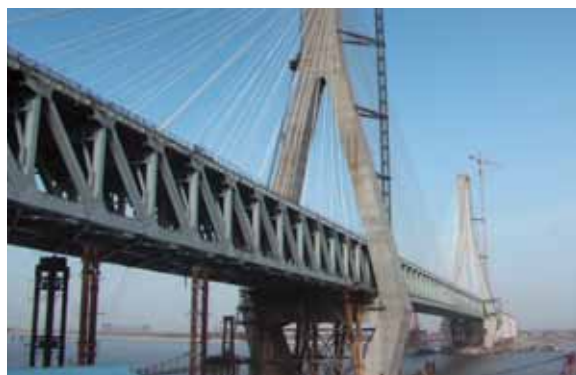
④ 建设中的武汉天兴洲长江大桥创4项世界第一。
