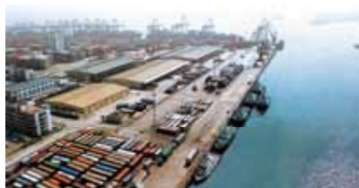
◎ 深圳蛇口港填海工程
